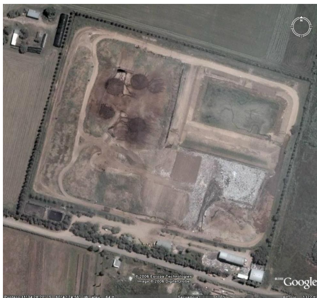
Vista Aérea del Relleno sanitario actual
